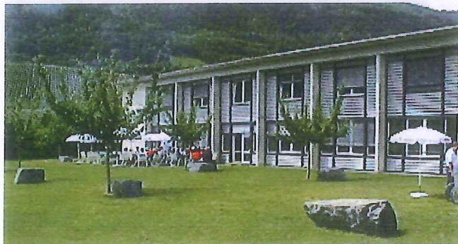
Das ehemalige kantonale Zivilschutzzentrum wurde mit grosser Liebe zum „Hotel Grône“ umgewandelt.
